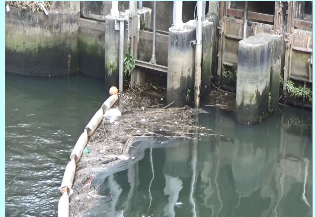
ごみを取り込む様子 (名城水処理センター)
