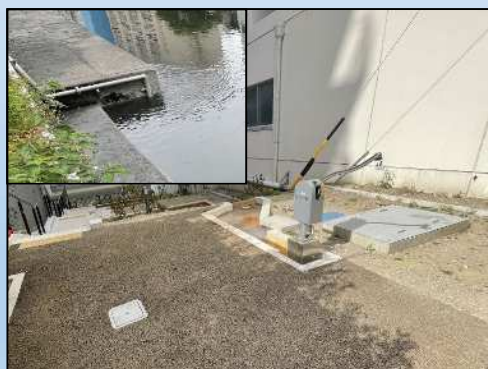
舞鶴橋上流井戸 放流箇所の様子
