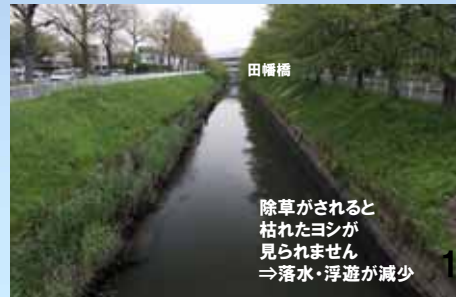
除草がされると枯れたヨシが見られません ⇒落水・浮遊が減少
