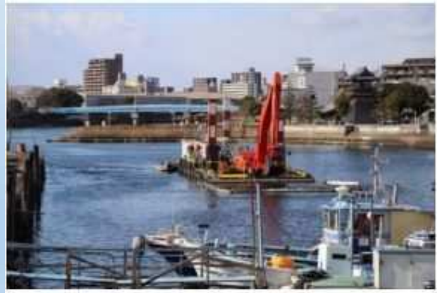
堀川合流点付近での浚渫実施状況
