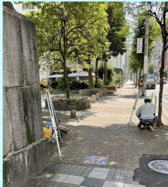
測量作業の様子（記念橋下流右岸）
