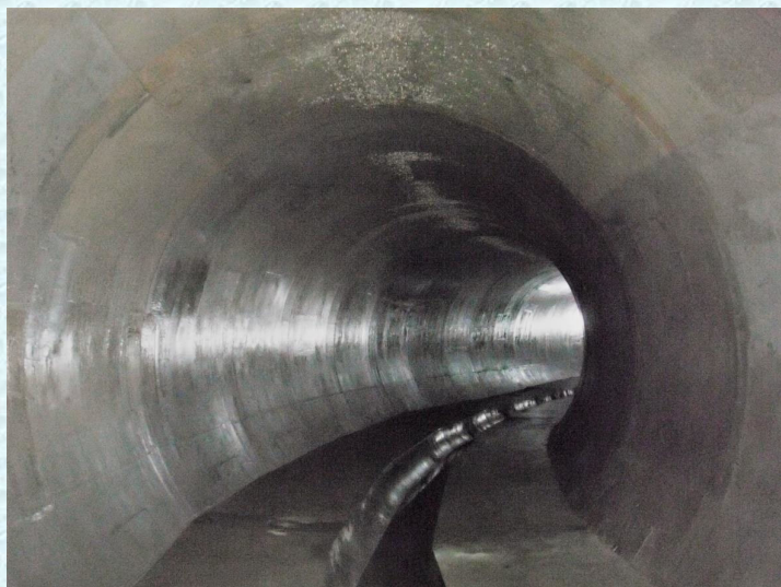
堀川左岸雨水滞水池
