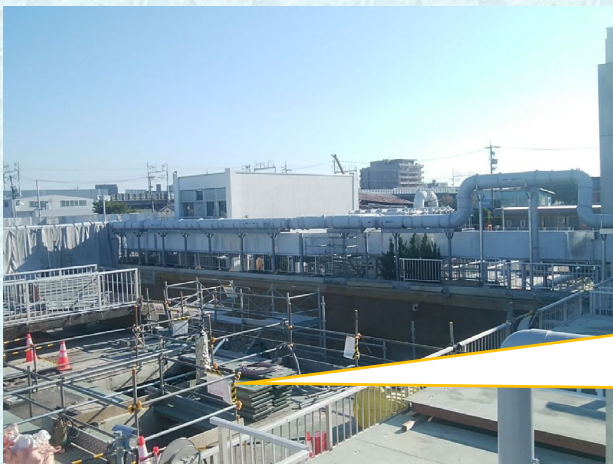
千年水処理センターの工事の様子
