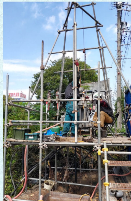
作業の様子（法螺貝橋上流左岸）
