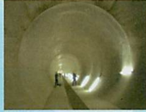
堀川右岸雨水滞水池
