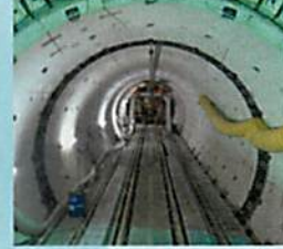
堀川左岸雨水滞水池
